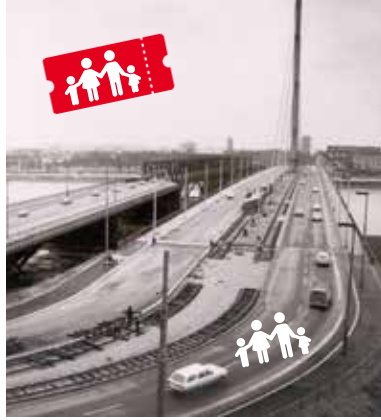
Die verschobene Oberkasseler Rheinbrücke, 1976
